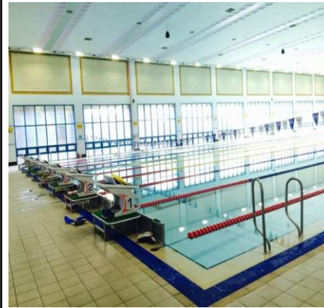
전북체육고 수영장 개보수
