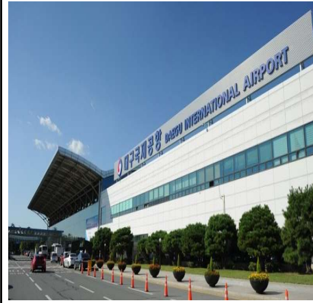
대구공항 공기조화기 교체 공사
