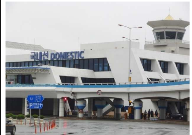
김해공항 국내선 공조기 교체 공사
