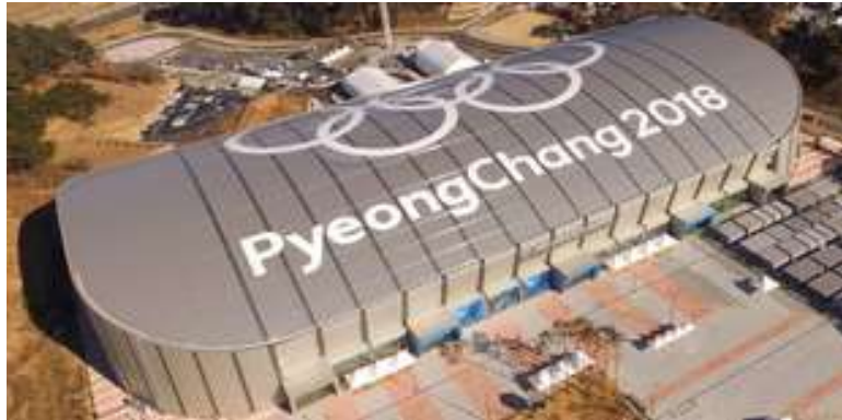
2018평창올림픽 스피드스케이팅 경기장 (강원 강릉시) 제습공조기 6대 | 2017. 2.
